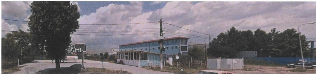
Figura 3. Imagine destructurată din zona studiată.
